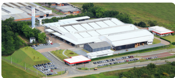
Engines Manufacturing Plant Planta de Producción de Motores
