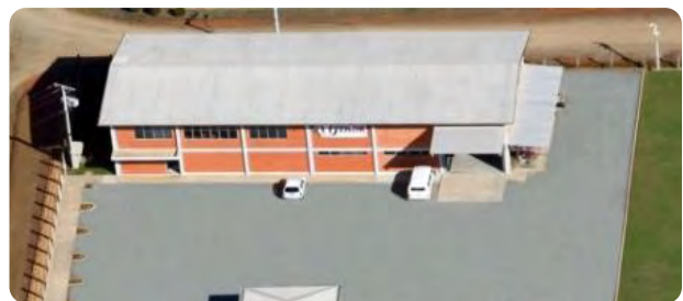
Electric Conductors Manufacturing Plant Planta de Producción de Conductores Eléctricos
